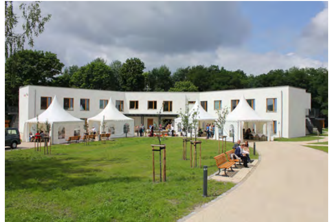
Fassade und Außenanlagen
